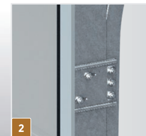
2 Skręcane prowadnice z ościeżnicą
